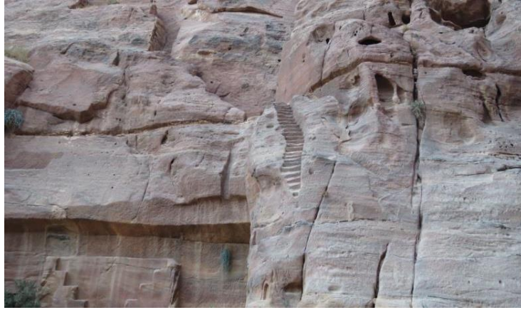
صورة تبين أدرجاً نُحتت في الصخر لغايات عمل صيانة لقناة المياه (تصوير الباحث)
